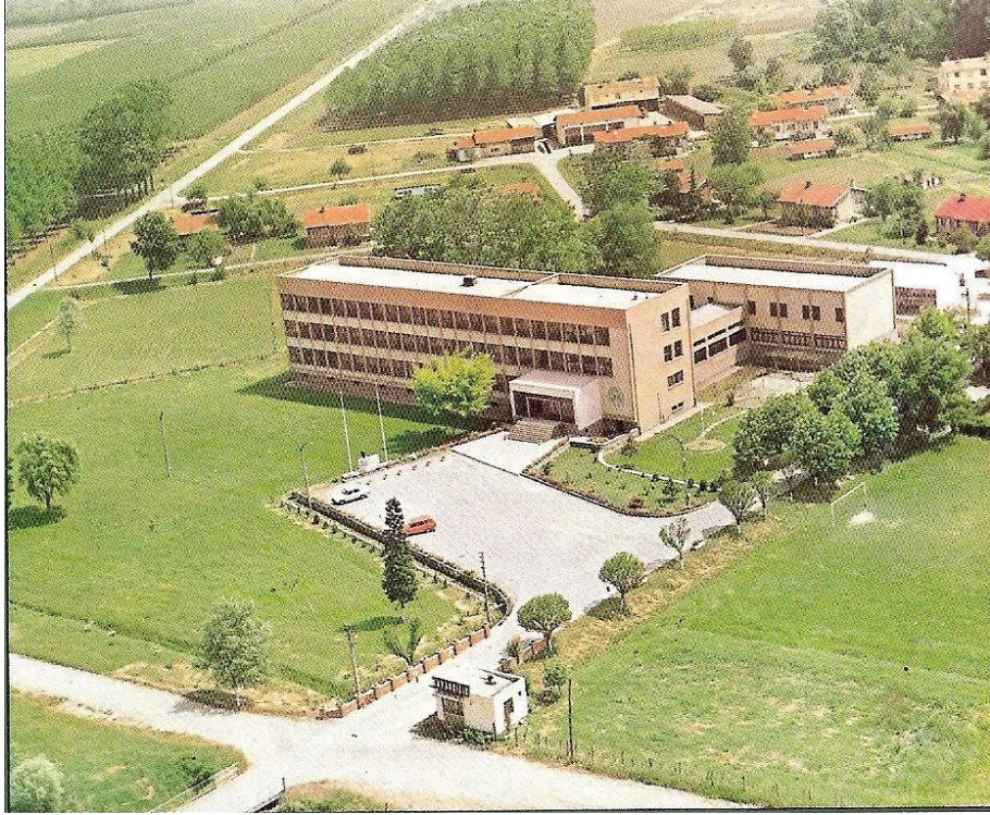
Resim 4: 1980'li yılların başlarında Enstitü binası
